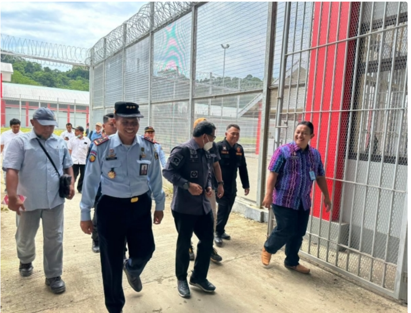
Plt. Kalapas Pasir Putih didampingi Sesditjenpas mengunjungi pembangunan Lapas baru di Nusakambangan
